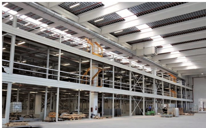
Il magazzino di Decathlon è dotato di un Pulsore® Autonomo MIX-IND® che integra la tecnologia brevettata BOX-IN-BOX.
